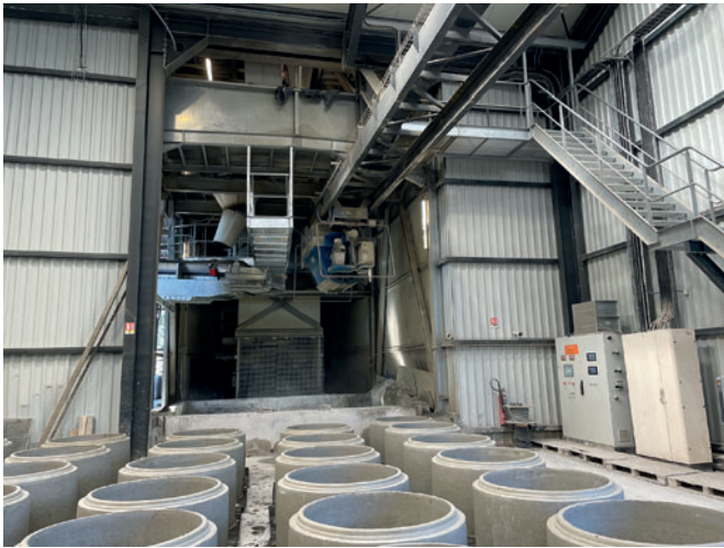
БСУ Teka приготавливает бетонную смесь для всех производственных участков
